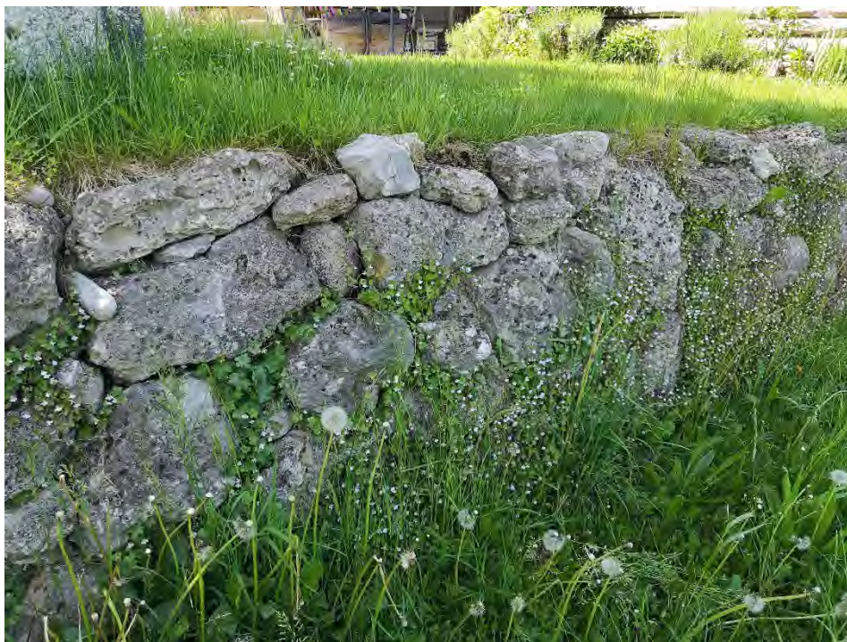
Abbildung 4: Unverfugte Steinmauer am westlichen Rand des Eingriffsbereichs.
