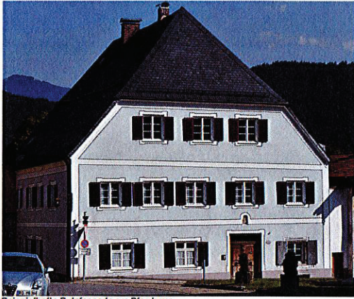
Beispielhafte Putzfassade am Pfarrhaus
