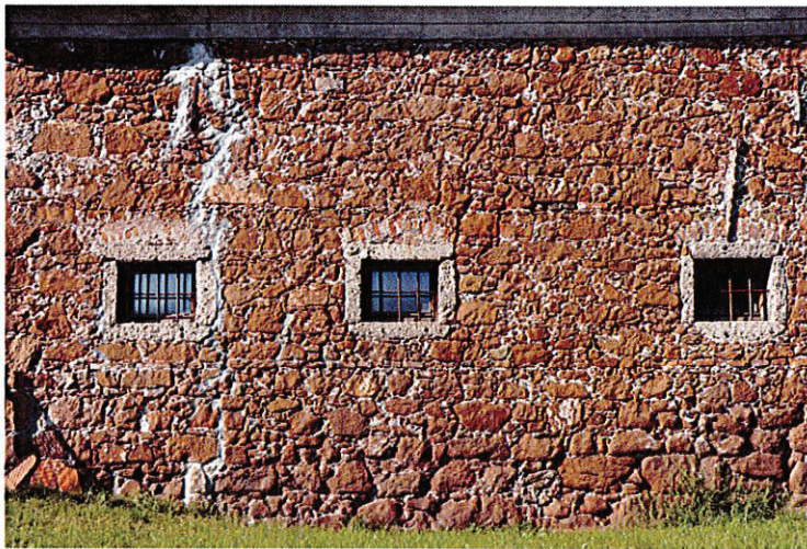
Bruchsteinfassade des alten Pfarrstadls
