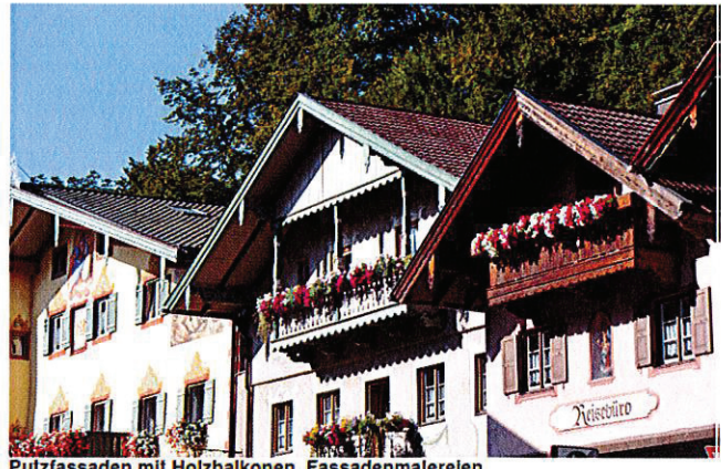
Putzfassaden mit Holzbalkonen, Fassadenmalereien
