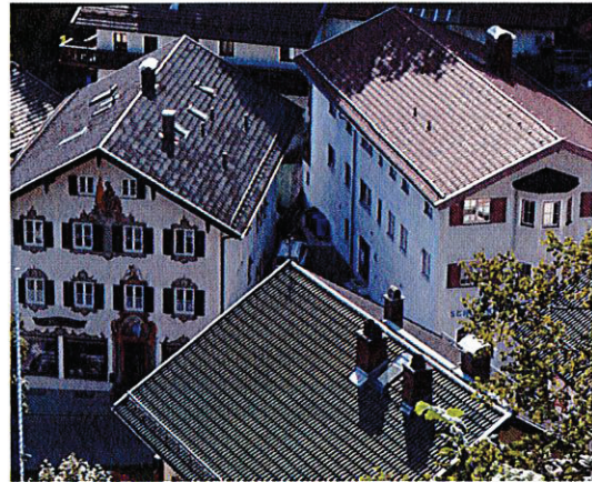
Ruhige, mit dunklen Dachziegeln gedeckte Satteldächer
